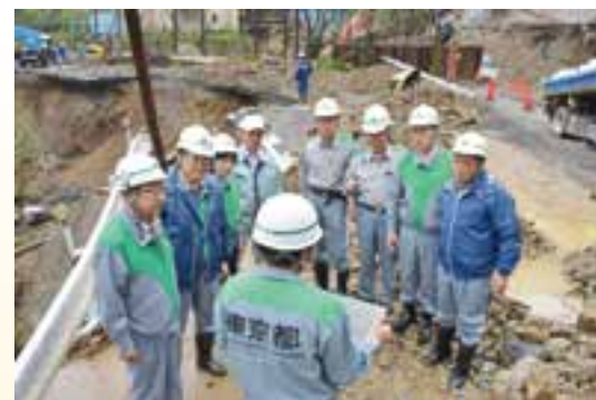
(10月18日・松原村道路崩落現場)
