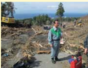
元町神達地区の被害状況を調査。
